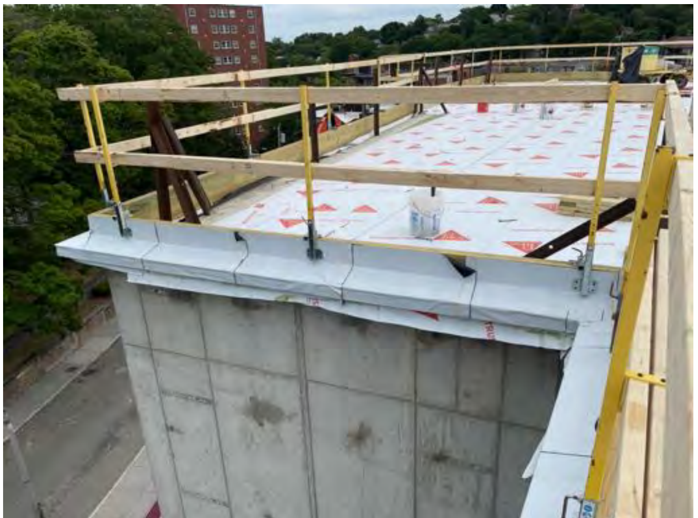
Roof edge progress, Area C.
