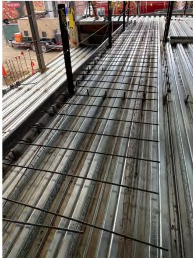
Slab prep, Area A.
