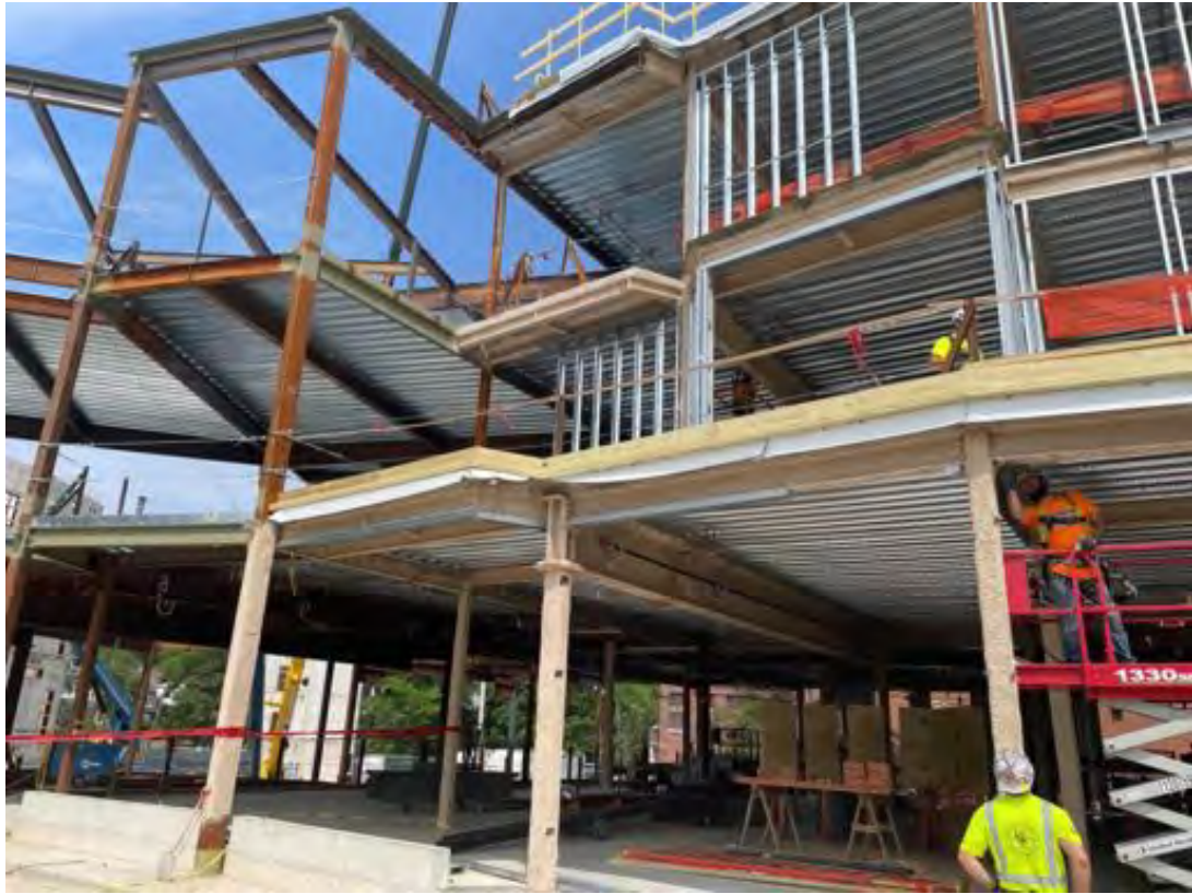
Roof edge level 3.
